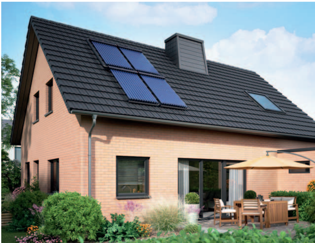
Vitosol 300-TM na streche rodinného domu
