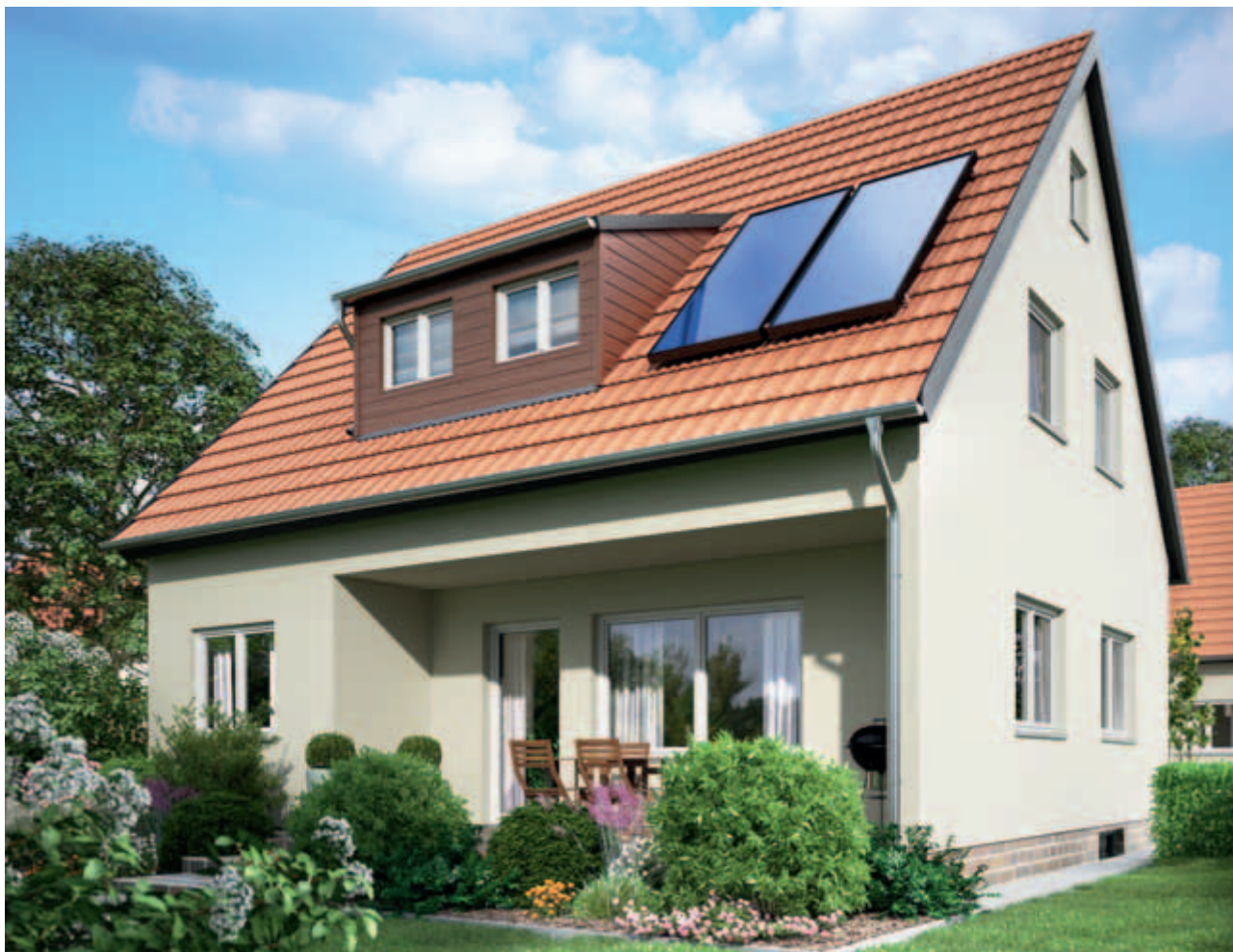
Vitosol 200-FM na streche rodinného domu
