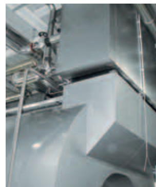
Nasadený ekonomizér na kotle Vitomax HS
