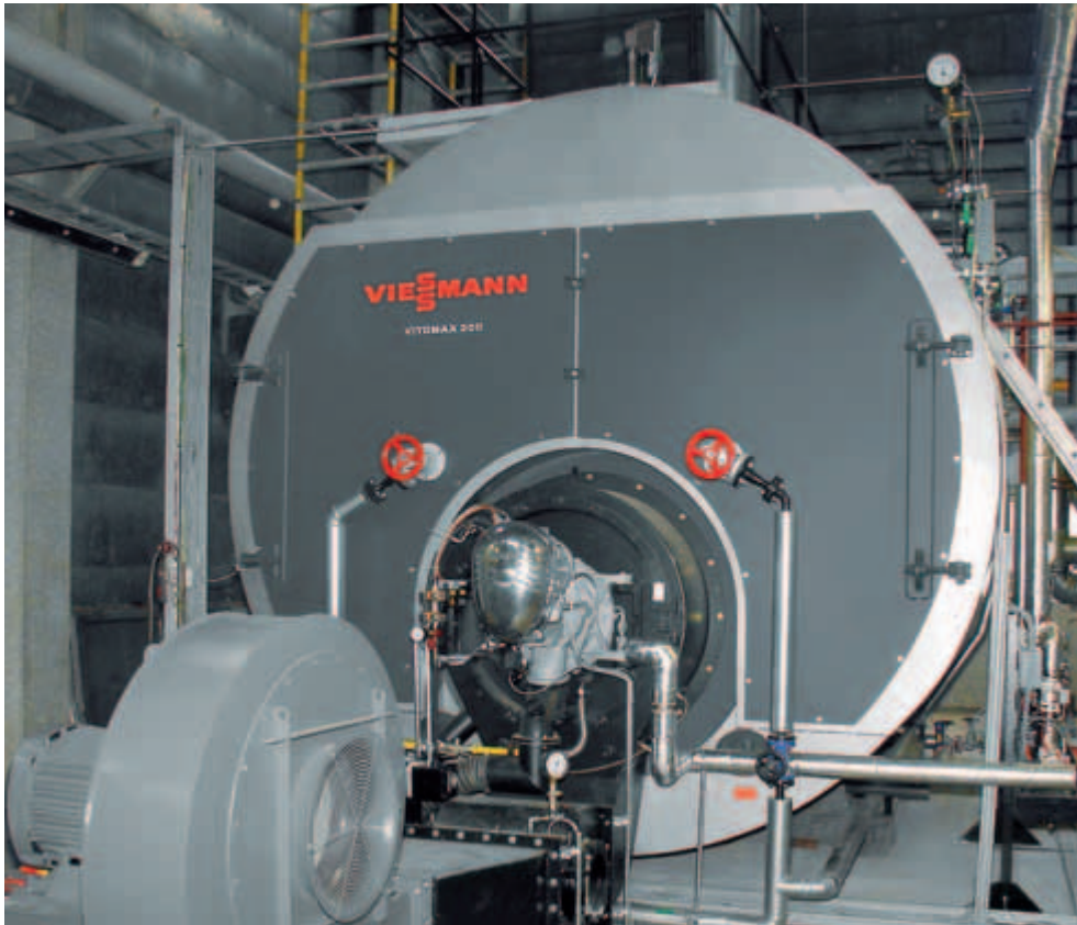
Parný generátor Vitomax HS v špeciálnom vyhotovení určenom na spaľovanie živočíšnych tukov
