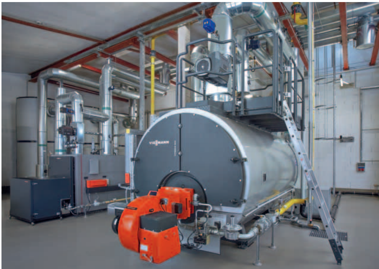
Vitomax LW – teplovodný kotol s plynovými horákmi
